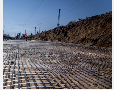
Enkagrid MAX 40 beépítése
