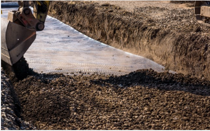
A szemcsés védőréteg beépítése az erősítő georács rétegre
