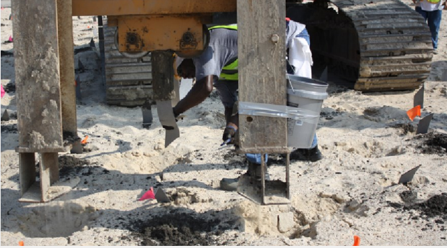
Az ún. "drénpapucs" felhelyezése a drénszalag végére, segítségével a geokompozit nem húzódik fel a szár kiemelésével együtt.
