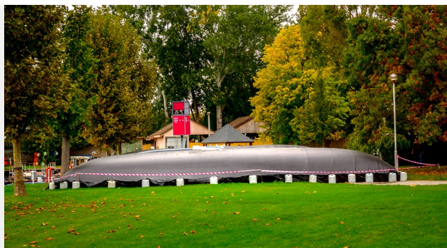
A két kisebb zsákot 2,3 méter magasra pumpálták, majd a nagyobbat csak ezután telepítették a két kisebb zsákra.
