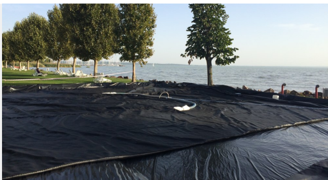
Kezdeti állapot, vízáró membrán telepítve, első zsák töltése.
