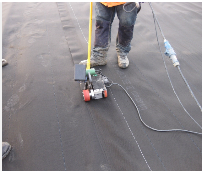
Az Enkadrain ZB 350 átfedéseinek hegesztése
