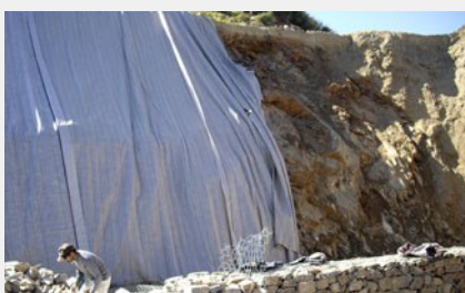
Enkadrain nagyon agresszív felhasználási feltételek között (szakítószilárdság és átszűrődással szembeni ellenállás)
