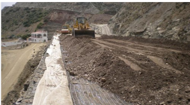
A feltöltés kiegyenlítése és tömörítése, gabion kosarak és ideiglenes szaluzat használata, elválasztó geotextília réteg a gabionokon
