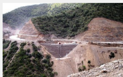
A megoldás minimalizálta a terhelést a meglévő részűkőn
