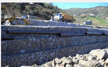
Enkagrid rétegek a talajréteg kiegyenlítése és tömörítése előtt
