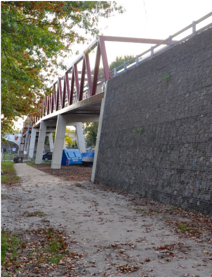
Aansluiting aanbrug op fietsviaduct 'De Gagel'
