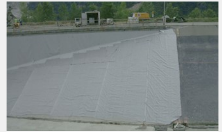
Pose de l'Enkadrain sur un rampant du divergent
