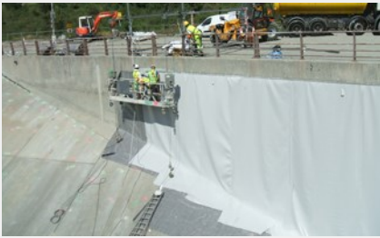
Pose de l'Enkadrain et de l'étanchéité sur les piédroits du divergent à la nacelle
