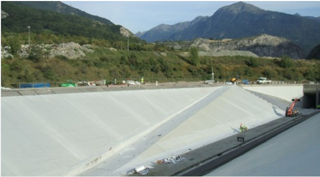
Rampe d'accès traitée au droit de l'avaloir divergent
