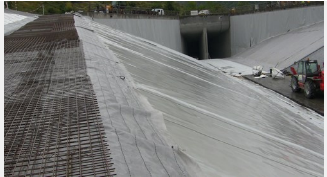
Pose de l'Enkadrain pour protéger la géomembrane de la rampe d'accès
