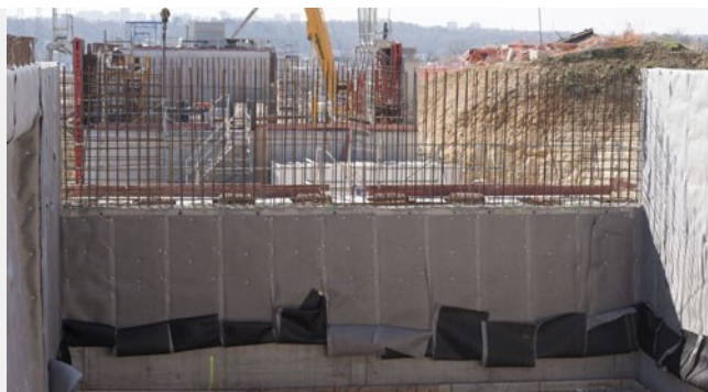
Pas de perte par recouvrement : l'Enkadrain intègre des languettes de 10 cm de recouvrement des filtres
