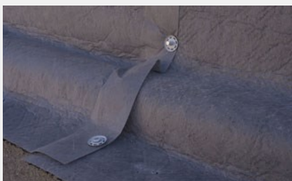
En pied, l'Enkadrain recouvre le tuyau, pas besoin de matériau graveleux additionnel
