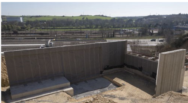
Vue d'ensemble d'une culée.
