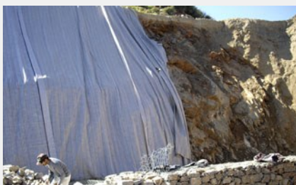
Enkadrain ® en conditions très agressives (solllicitations en traction et poinçonnement)
