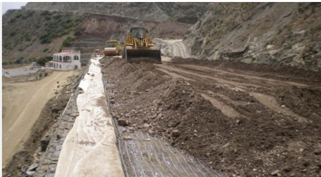
Nivellement et compactage du remblai, les gabions servant de coffrage, nappe Bontec en attente
