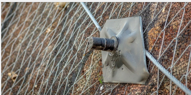
Platine P33, maille en fil d'acier haute résistance TECCO et Enkamat 7010
