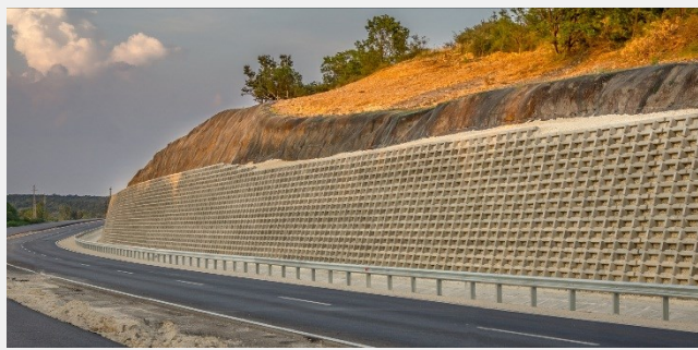
Vue d'ensemble mur de soutènement et talus supérieur
