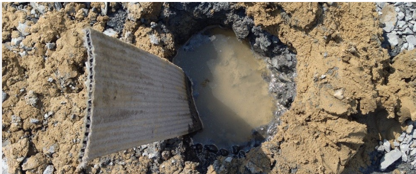
Colbondrain CX1000 munkában
