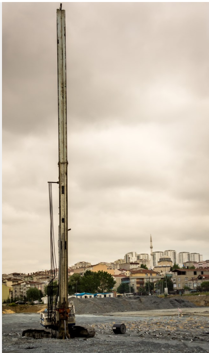
Tipikus leszúró túske a Colbondrain CX1000 telepítéséhez
