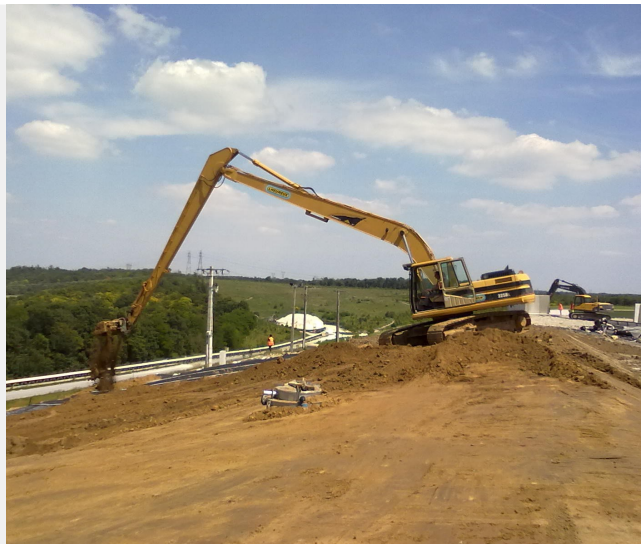
Installation de sol de couverture avec une pelle à long bras Caterpillar 325 BL
