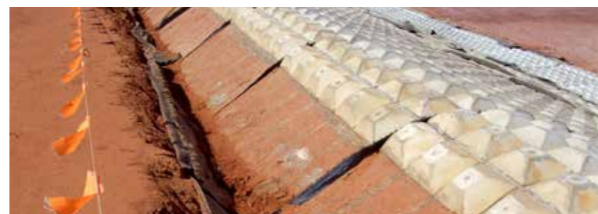
A rögzítőárok kitöltése betonnal
