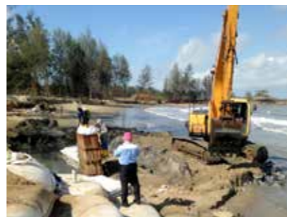
Az Enka-G-Bag helyszíni homokkal kerül megtöltésre, mellyel elkerülhető a sziklák vagy töltőanyag szállítása.
