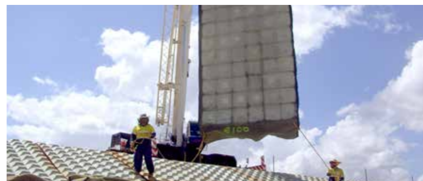
Az Enka-Fix elég erős ahhoz, hogy a beton matracokat a levegőben is megtartsa
