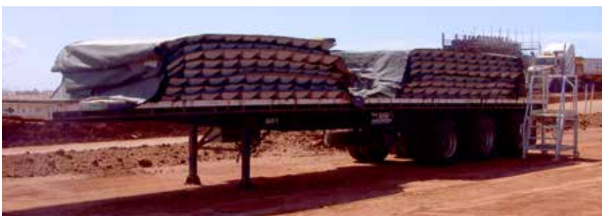
Vervoer van de 2,6 m brede flexibele betonmatrassen
