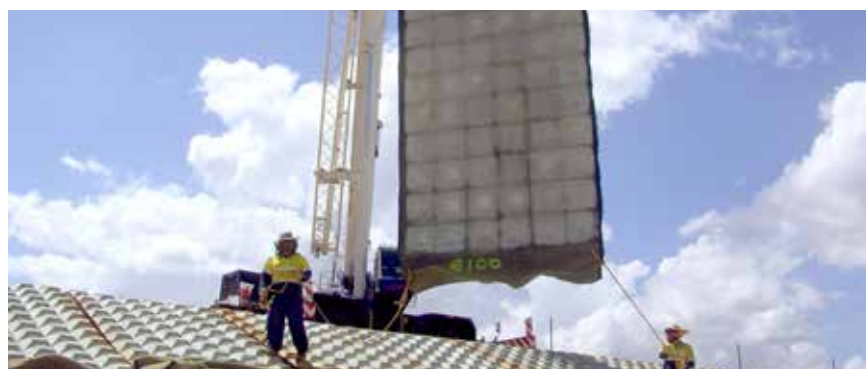
Enka-Fix is sterk genoeg om de betonmatten te kunnen ophijsen
