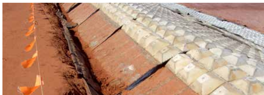
De verankeringsleuf werd met beton gevuld
