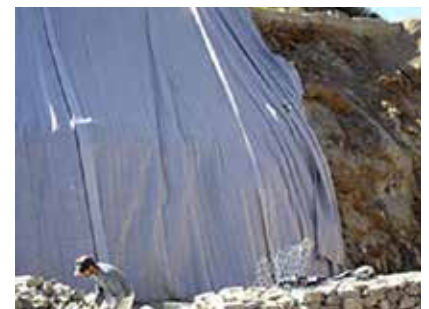
Barre omstandigheden vragen om een Enkadrain-product met een grote treksterkte en perforatieweerstand
