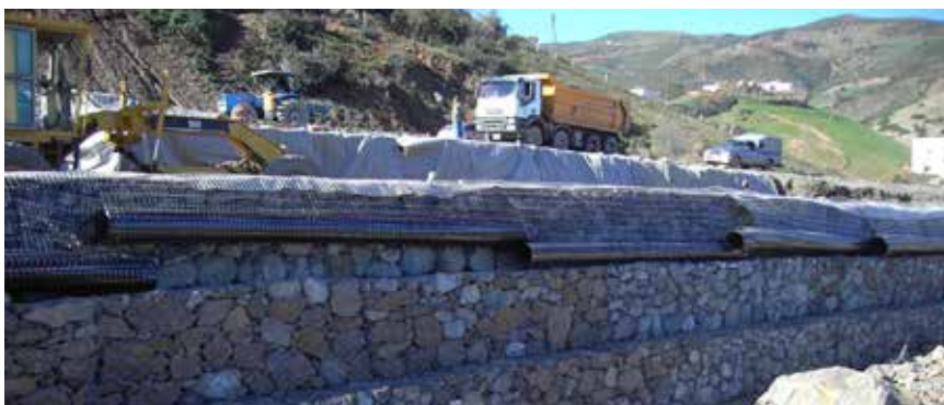
Enkagrid-lagen tijdens het egaliseren en verdichten van grondlagen
