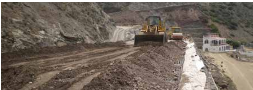
Egaliseren/verdichten van de aanvulgrond; het gebruik van zowel schanskorven als tijdelijke bekisting; Enka-Tex scheidingslagen tussen de schanskorven
