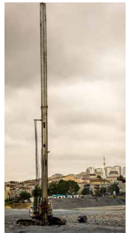
Typisch voorbeeld van een stelling voor de installatie van Colbondrain CX1000
