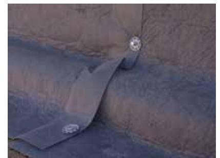
Onderaan dekt Enkadrain de buis af: extra grind is hier overbodig
