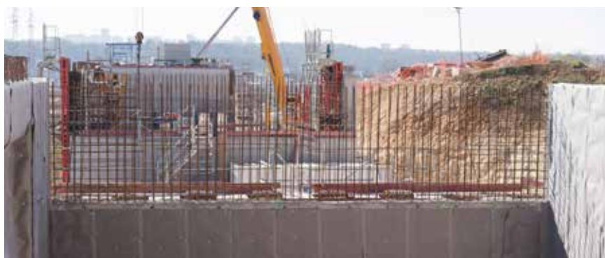
Geen verlies door overlappings: Enkadrain is voorzien van 10 cm brede overlappings van filtervlies
