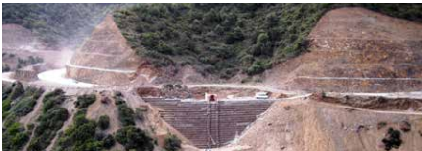
Keerwand constructies met Enkagrid ter ontlasting van de belasting op bestaande hellingen
