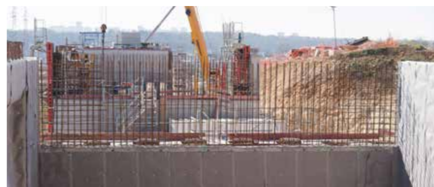
Nincs veszteség az átfedések miatt: az Enkadrain 10 cm átlapoló geotextíliával van ellátva
