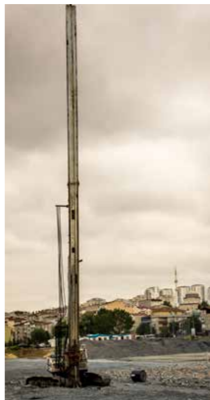
Típusos leszűrő tüske a Colbondrain CX1000 telepítéséhez
