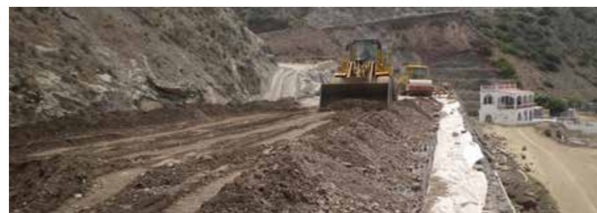
A feltöltés kiegyenlítése és tömörítése, gabion kosarak és ideiglenes zsaluzat használata, elválasztó geotextília réteg a gabionokon
