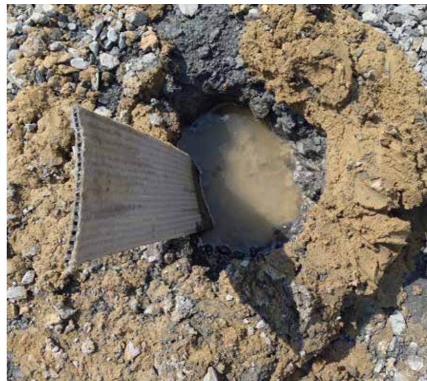
Colbondrain CX1000 munkában
