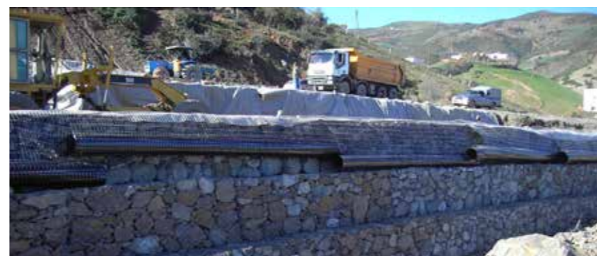
Enkagrid rétegek a talajréteg kiegyenlítése és tömörítése előtt
