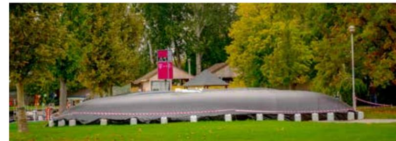
Die beiden kleineren Schläuche werden bis auf eine Höhe von 2,3 m gefüllt. Der größte Schlauch wird auf die beiden kleineren Schläuche gelegt.
