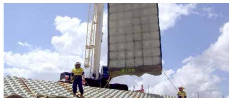
Die Zugfestigkeit von Enka-Fix ermöglicht das Anheben der fertigen Matte.
