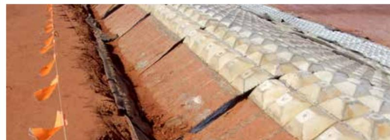
Der Verankerungsgraben wurde mit Beton verfüllt.
